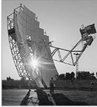
نمونه ای از دیش سهموی و جذب کننده آن که برای تولید برق
