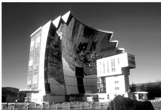
نحوه بازتاب از آینه های تخت به محدب برای تمرکز نور در کانون آن
